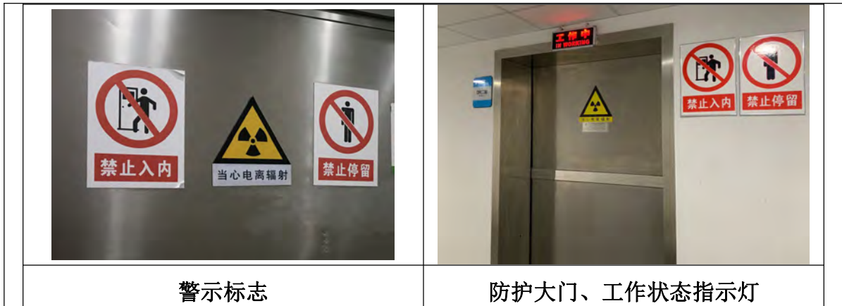
图3-5 放射科DR机房入口处防护门
