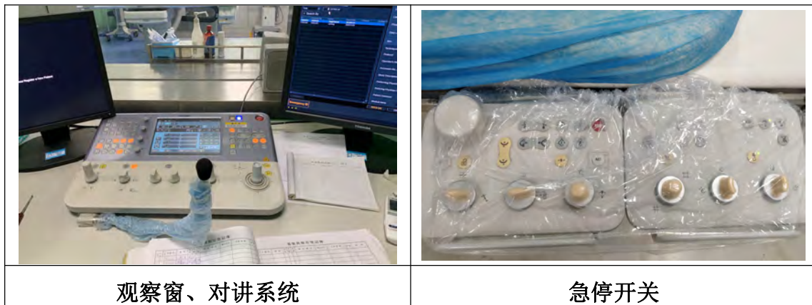
图3-2 介入手术室DSA机房观察窗、对讲系统、急停开关
